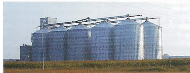
Zentrales HANSA-Getreidelager in Mulmshorn Reinigung, Hygiene und Gesunderhaltung sind Kernpunkte der Getreidelagerung"
