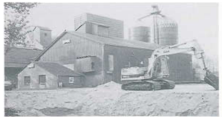
Bau der neuen Getreidelagerhalle in Wilstedt
