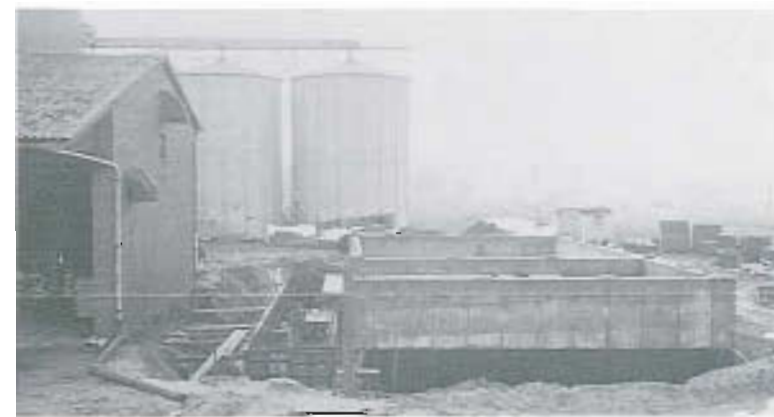
Die Baustelle in Ostereistedt
